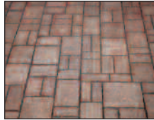
Modules 1 et 2 en assemblage parquet
